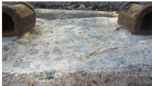
(d) Severe curve RSD in track
