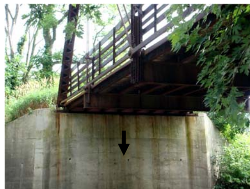
(d) New abutment
