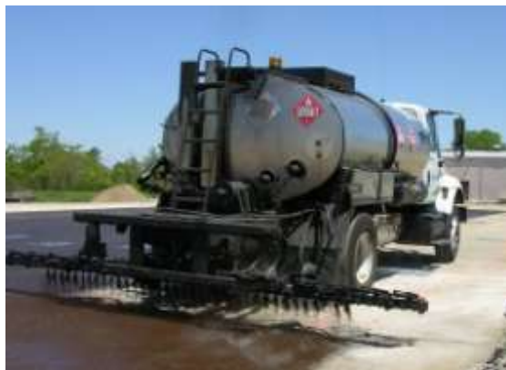
(d) Tack coat application on the existing surface.
