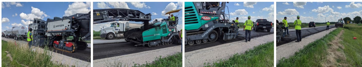
Figure 200. Photos. IL 116 CIR process.
