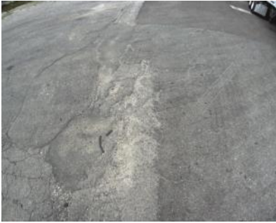
7.3. Edge Cracking
